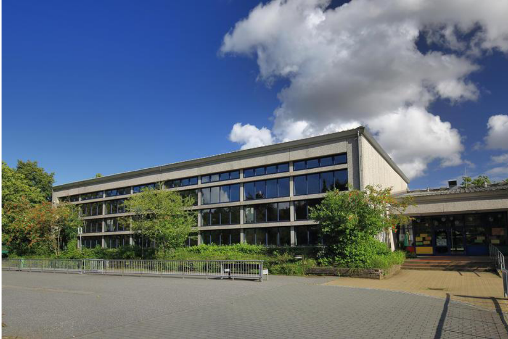
Abbildung 5: Die Turnhalle der Grundschule Steinbergkirche
